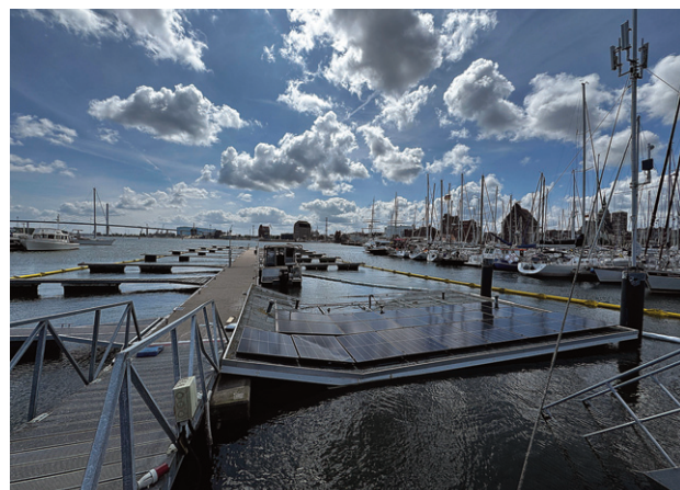
Das Dach des untergegangenen Sanitärgebäudes an der Nordmole, hier noch mit den Solarpaneele
