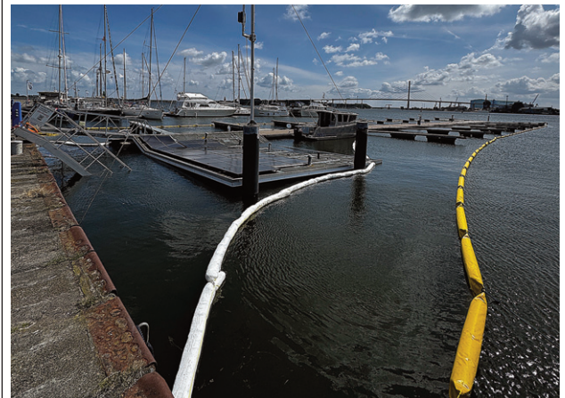
Das Dach des untergegangenen Sanitärgebäudes an der Nordmole. Fotos (3): HANSESTADT Stralsund | Pressestelle
