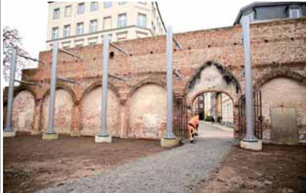
Die Außenwand der Klosteranlage St. Johannis wurde mit einer Stützkonstruktion gesichert.
